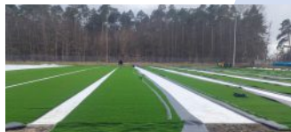
Budowa sztucznej nawierzchni na boisku bocznym treningowym, fot. CSiR
